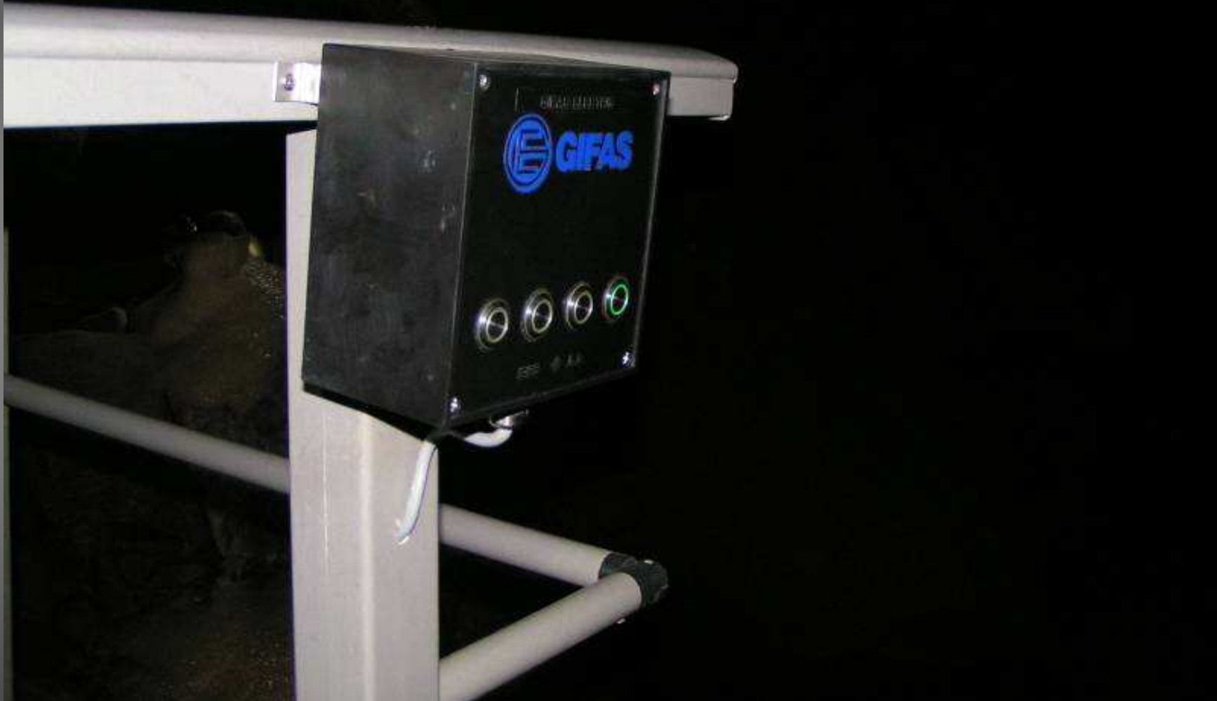
Schaltpult für die Beleuchtungssteuerung
