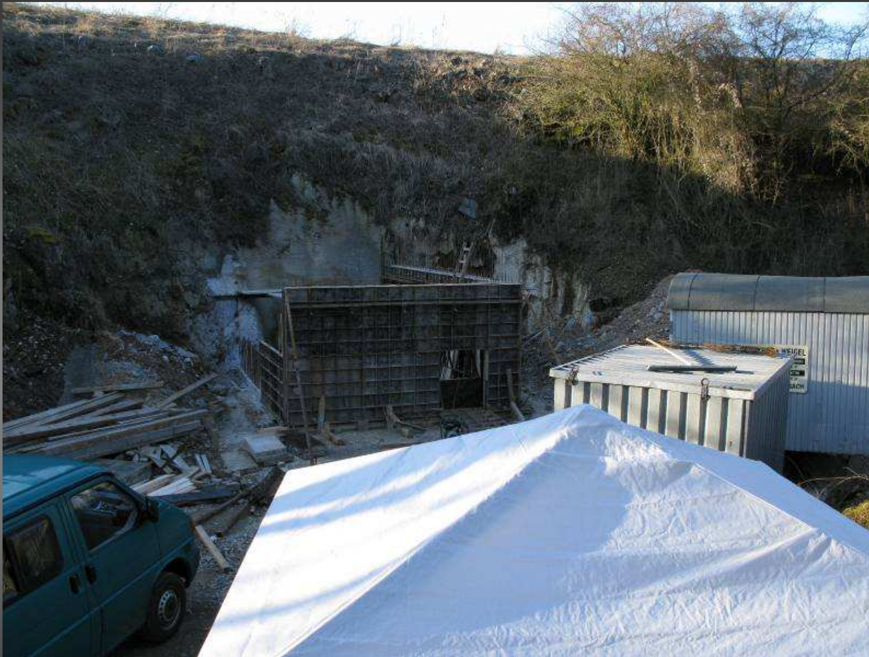
Errichtung des Außenbauwerks
